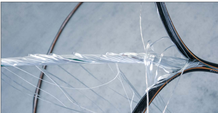
Dénuder manteau du câble 5.5 m
